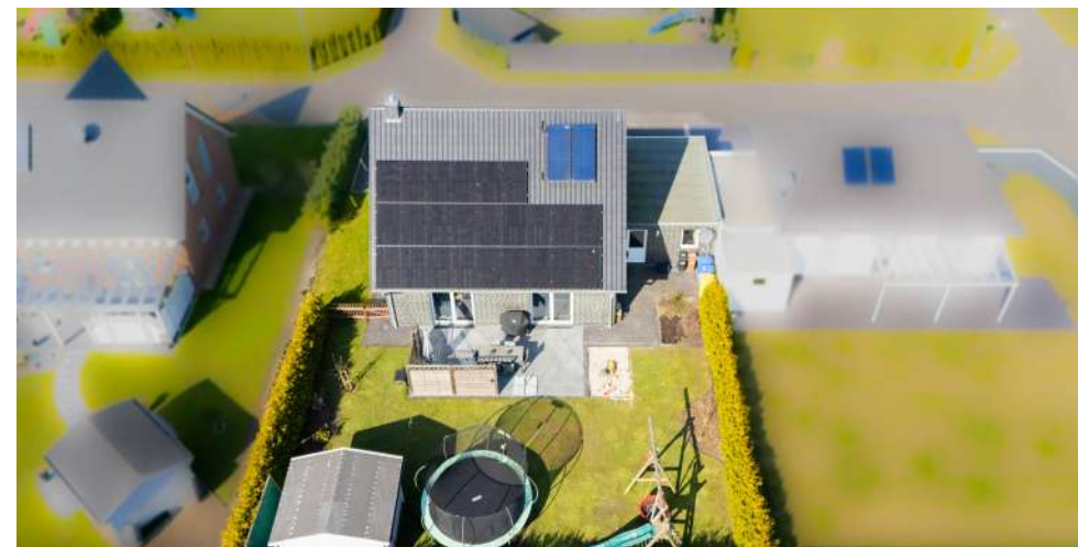
Photovoltaik 9,6kWp zzgl. 8,8 kWh Speicher und Solarthermie
